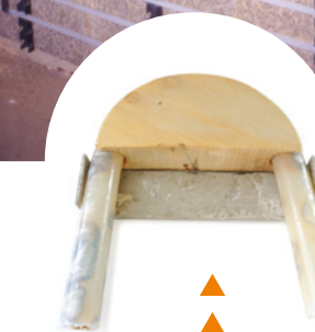
◀ Das 1. Biegemodel für die ersten Systemwände wurde mit dem Rohr an der Wand fixiert und verputzt
