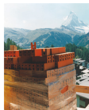
Speichersteine für ein Tepidarium in einem Hotel am Fuße des Matterhorns
