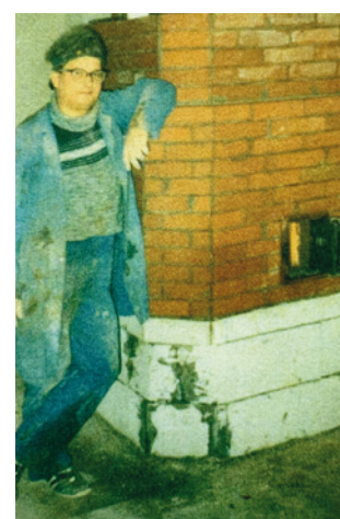
Prototyp der Kachelofen-Zentralheizung
